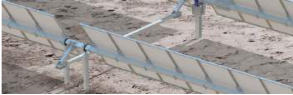
Figura 6.- Detalle del sistema de transmisión lineal
